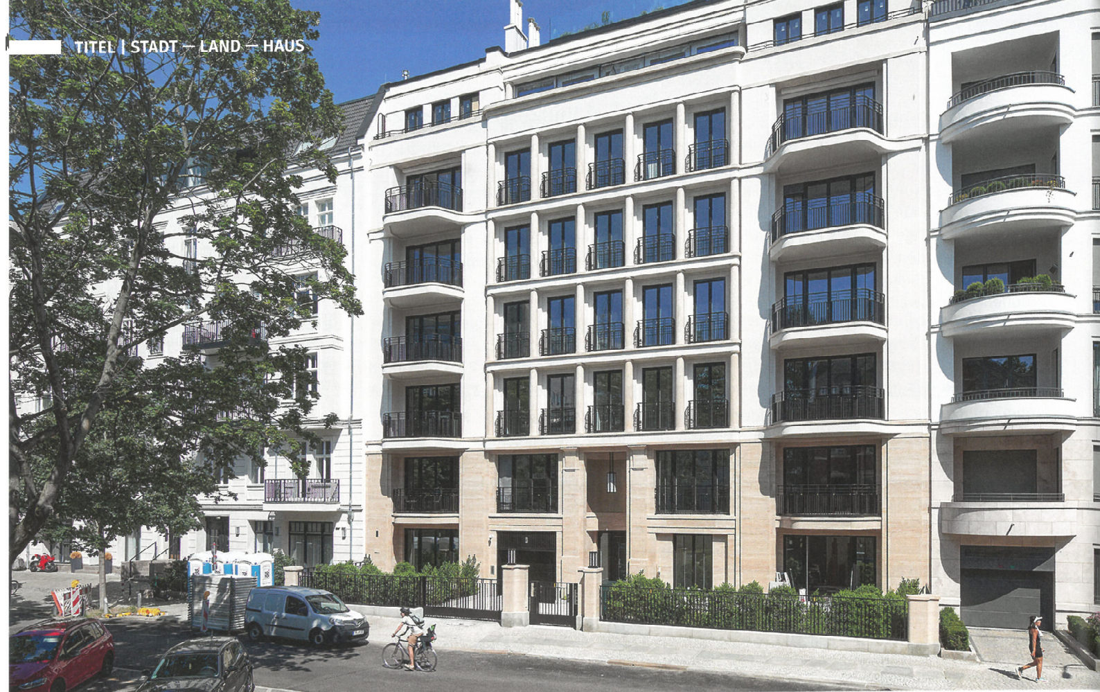
Von Tobias Nöfer umgesetztes Projekt in der Fasanenstraße in Berlin.
